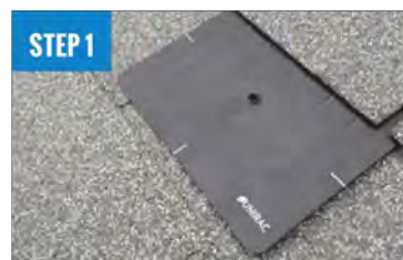
INSTALL FLASHKIT PRO FLASHING
